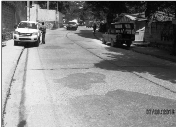
Réparations du revêtement en béton
