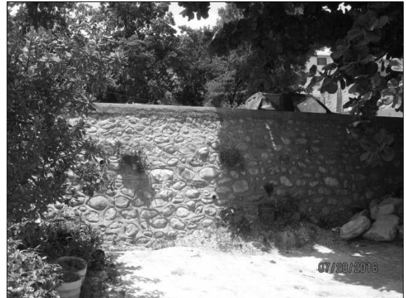
Mur de soutènement construit par le projet
