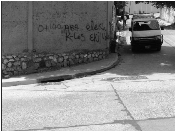
Rue Chavannes. Joints entre sections bétonnées
