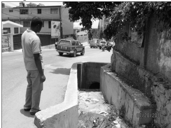
La tête du drain souterrain
