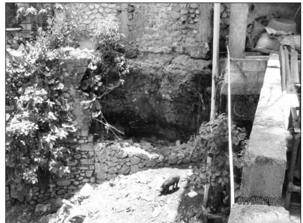
L'évacuation de l'eau dans la ravine, existante et sous-dimensionnée, au-dessous de la maison à démolir
